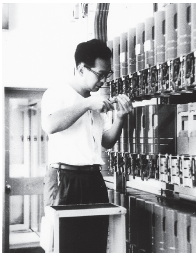
ステップ・バイ・ステップ自動交換機の 200万回動作試験でワイパー交換を行っ ているところ
